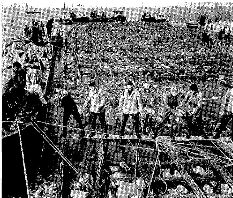
Het aanbrengen van lichte ballast
